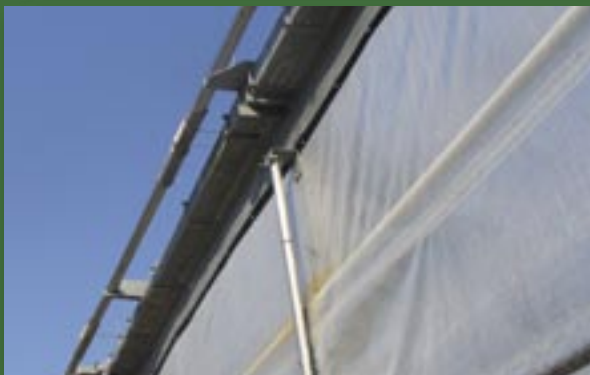
Los tirantes de los postes laterales su pueden colocar en el interior o en el exterior
