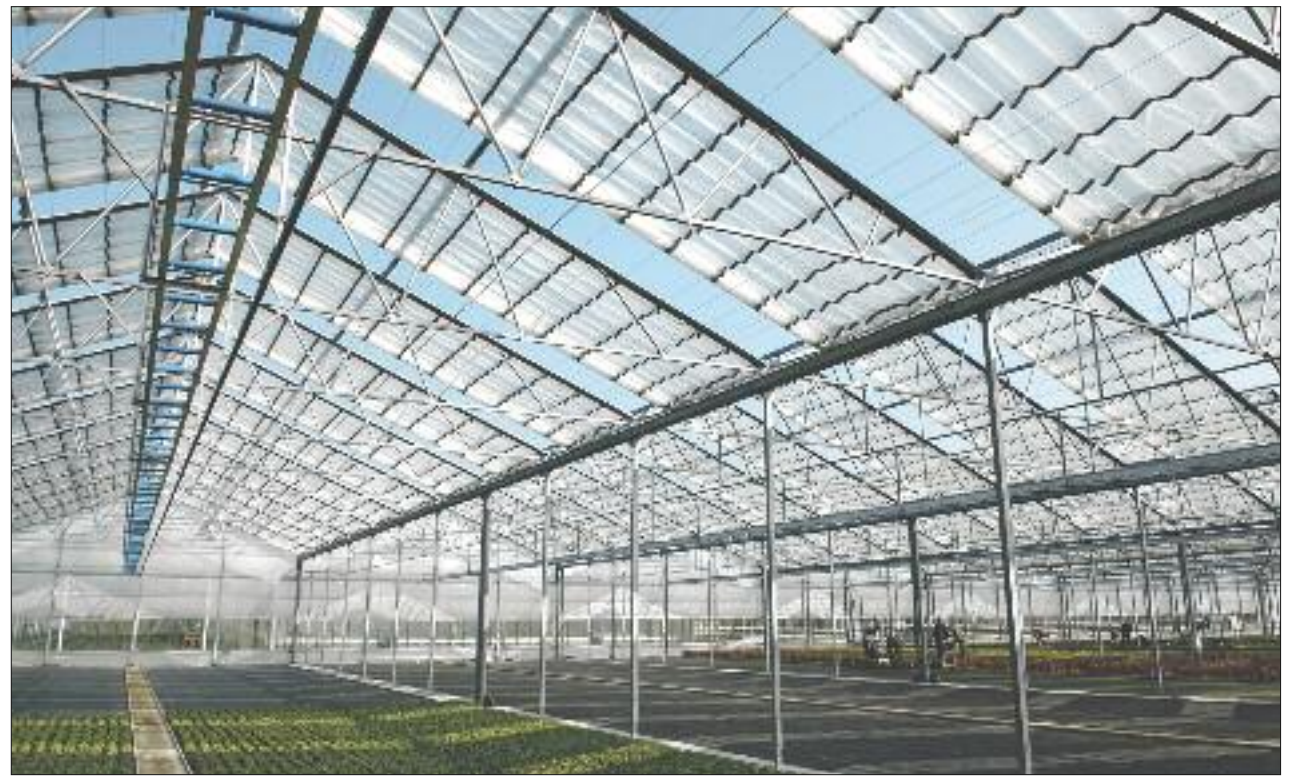
Aus Kanada stammt dieses Folienhaus, in dem die Folie wie bei Energie- oder Schattirschirmen zusammengefahren werden kann und so Freilandbedingungen herrschen.
