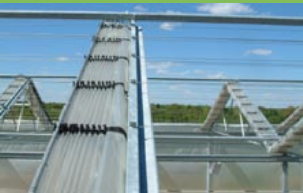
La punta de la cumbrera integra el techo y la estructura
