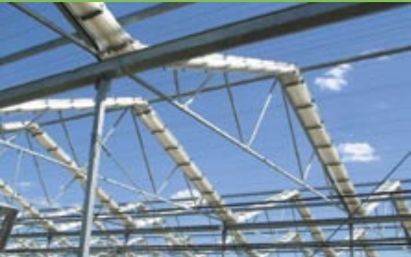
La punta de la cumbrera integra el techo y la estructura
